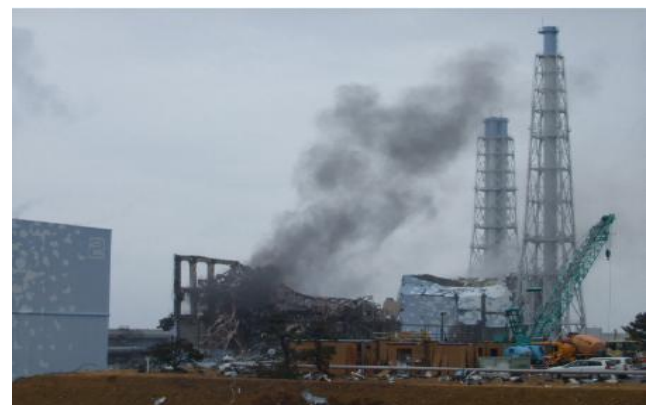
10. ábra: 2011. március 21-én készült fénykép a súlyosan megromgálódott 3. (középen) és 4. (jobbra) blokk reaktorépületeiről. A 2. blokk a kép bal szélén látható.
