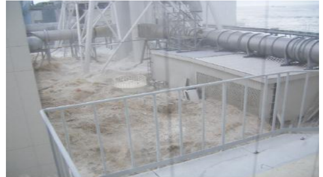
9. ábra: Fénykép a Fukushima Daiichi Atomerőmű területén kialakult elárasztásról, a Radioaktív Hulladék Kezelő Létesítmény (Radiation Waste Treatment Facility) északi oldalán, 2011. március 11-én. A méretarányt a fémajtónak támaszkodó jármű hátulja szemlélteti.
