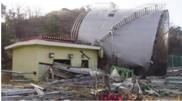
13. ábra: Felborult nehézolaj-tartály [9]
